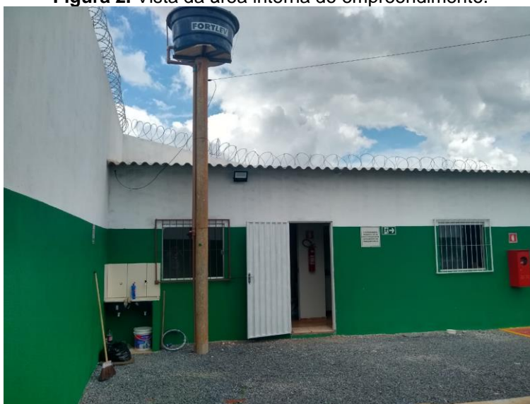
Figura 2. Vista da área interna do empreendimento.
