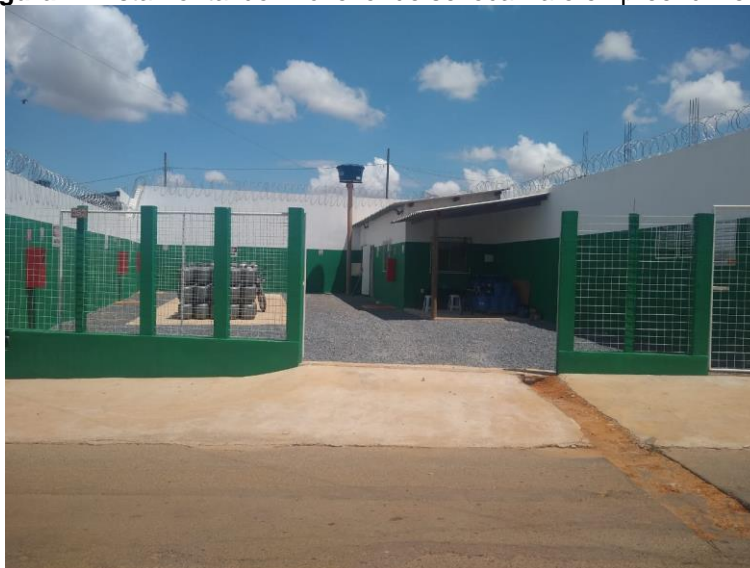
Figura 1. Vista frontal do imóvel onde se localiza o empreendimento.
